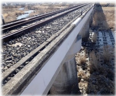
橋梁補修工事 (第一盛川)
