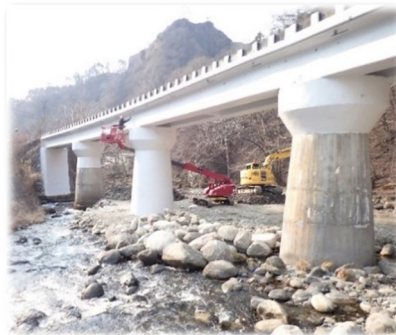
橋梁はく落対策工事 (第二盛川)
