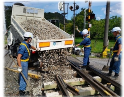
踏切敷板交換工事 (長安寺北部踏切)
