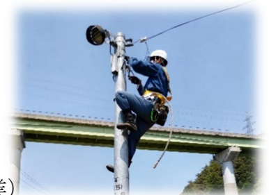
踏切照明工事
